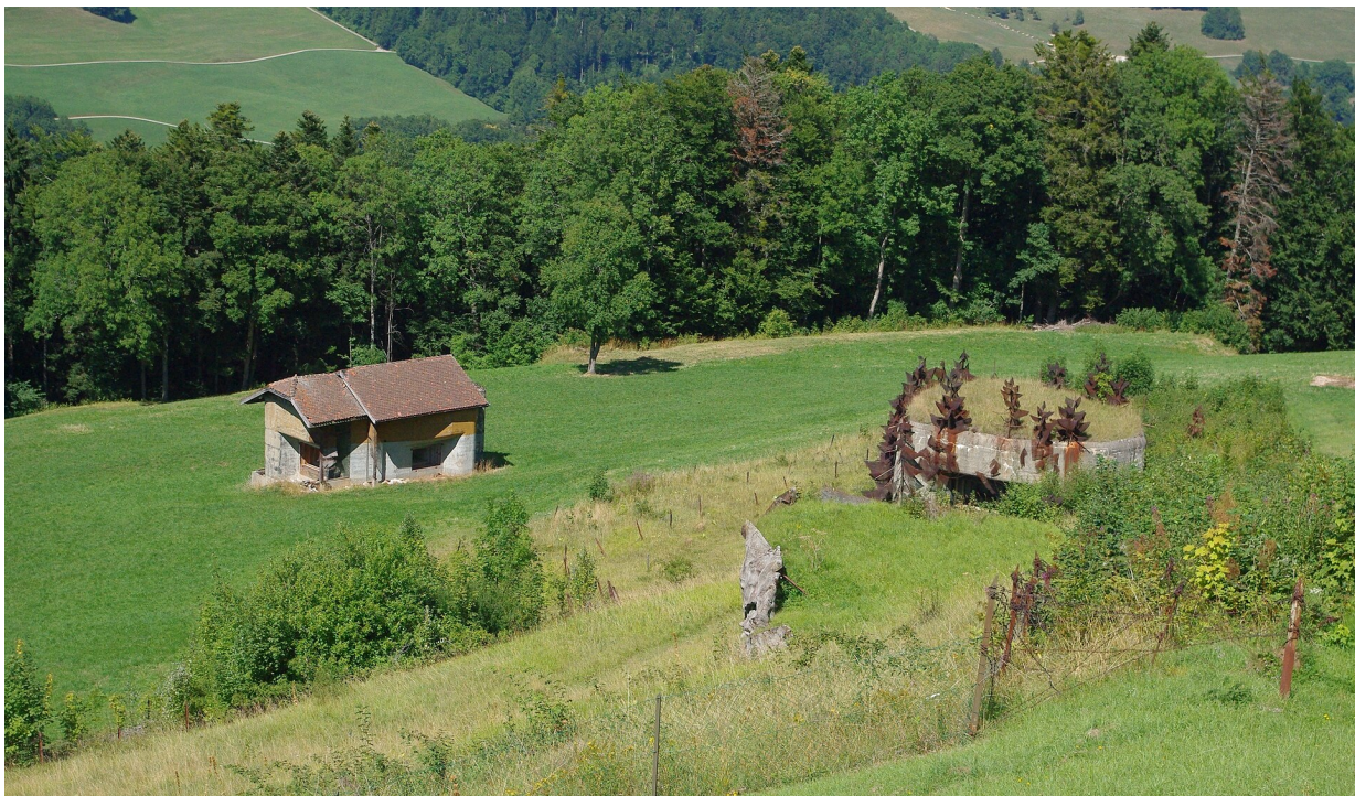
Deux casemates du fort militaire de Pré-Giroud, près de Vallorbe, conçus pour interdire le passage du Col de Jougne.
